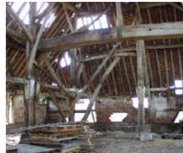
Le toit, crevé par endroit, laisse passer l'eau qui a rongé la charpente en plusieurs points. A l'intérieur de la grange, la charpente a été amputée et rafistolée au cours des années. Les 30.000 tuiles sont déposées avant le démontage de la charpente.
