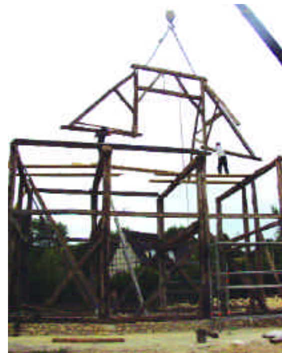
Le jour du levage, portées par le bras d'une grue, les fermes quittent unes à une les sol.
