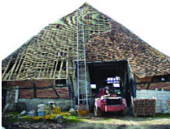
Le toit, crevé par endroit, laisse passer l'eau qui a rongé la charpente en plusieurs points. A l'intérieur de la grange, la charpente a été amputée et rafistolée au cours des années. Les 30.000 tuiles sont déposées avant le démontage de la charpente.
