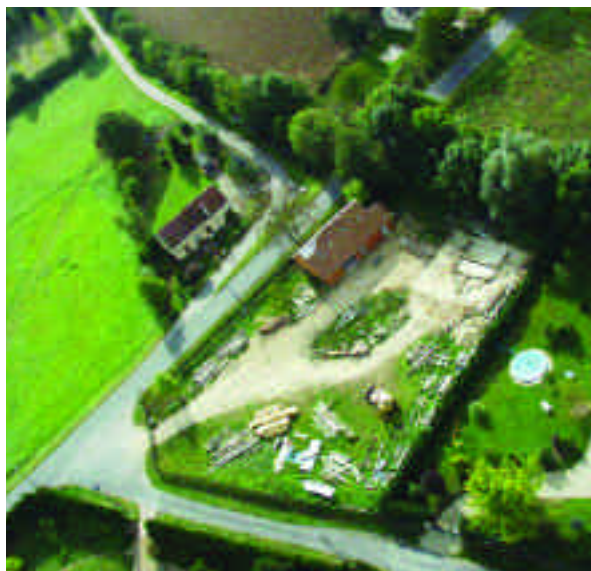
Vue d'ULM du chantier de reconstruction. Une ferme est assemblée au sol à l'endroit même où sera remontée la grange.
