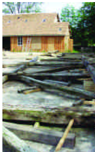
Sur une épure sont inscrites toutes les dimensions de la grange à reconstruire. Puis chaque pièce est retaillée, les tenons et les mortaises retracés avant l'assemblage des fermes au sol (ici avant levage).
