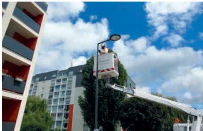
Intervention sur un luminaire
