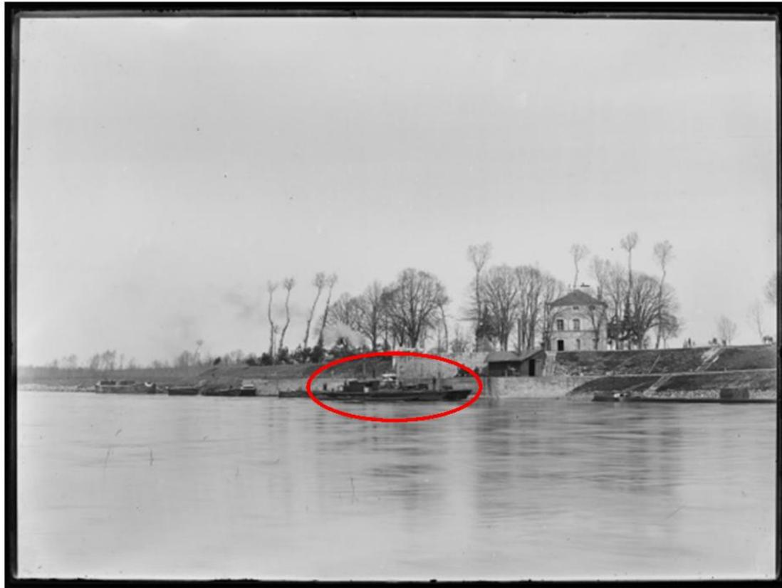
L'écluse des Combles photographiée vers 1895. Au centre, on voit le toueur à vapeur qui faisait traverser la Loire aux bateaux entre les Combes et Mantelot.
