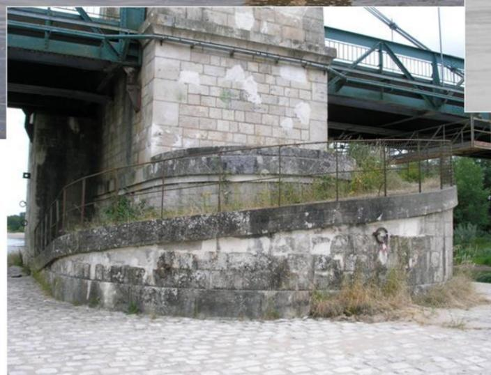
La rampe dite de « l'escargot » permettait aux chevaux de descendre sur le chemin de halage après avoir traversé le pont.
